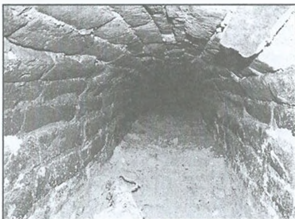
4. kép: A füstelvezető csatorna (KGYM Fotótára)
